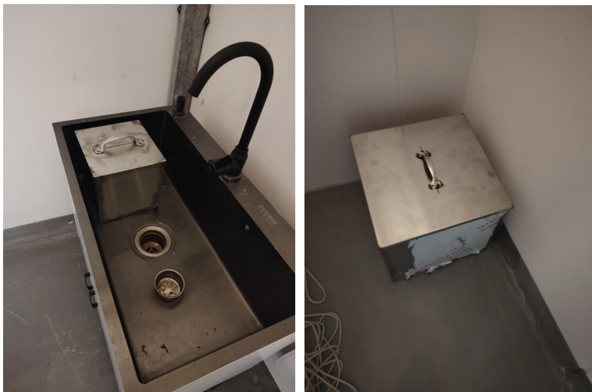
图4-7 放射性废液衰变箱、铅废物桶
